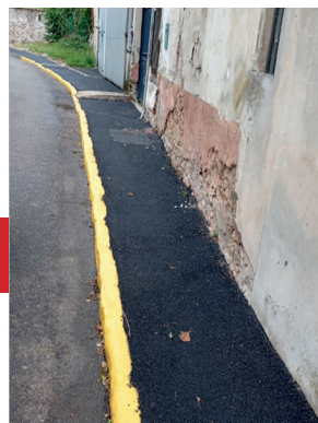
Trottoir rue de Courcelles
